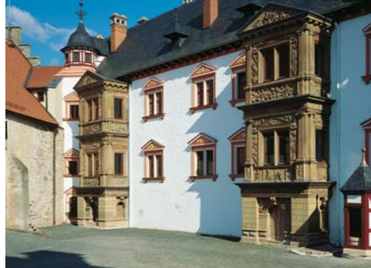
Hoffassade des Französischen Baus
