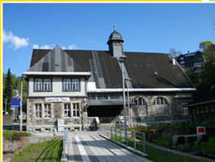
Empfangsgebäude des Bahnhofs
